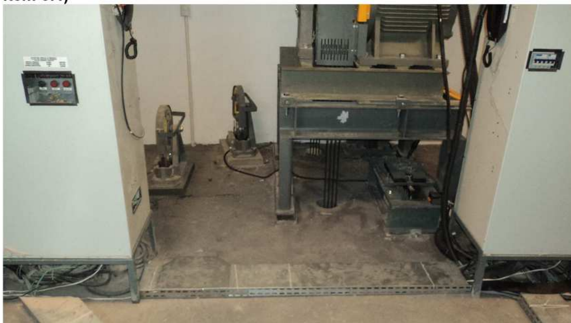
Foto 4 - Detalhe da máquina de tração e regulador de velocidade (Obs: item 3.4)
