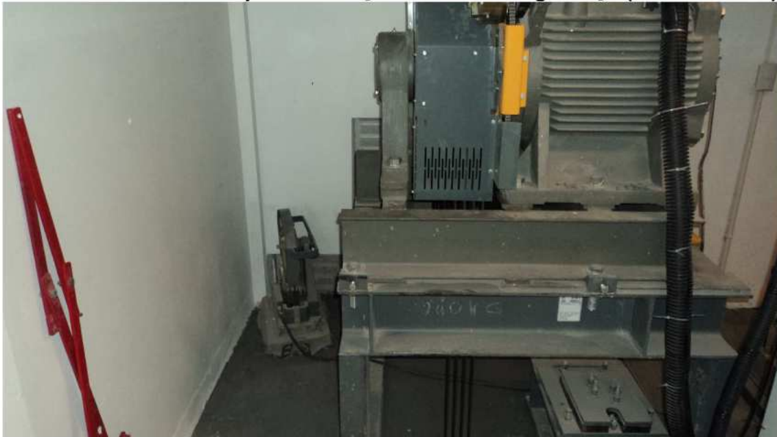
Foto 5 - Detalhe da máquina de tração e freio de segurança (Obs: item 3.4)
