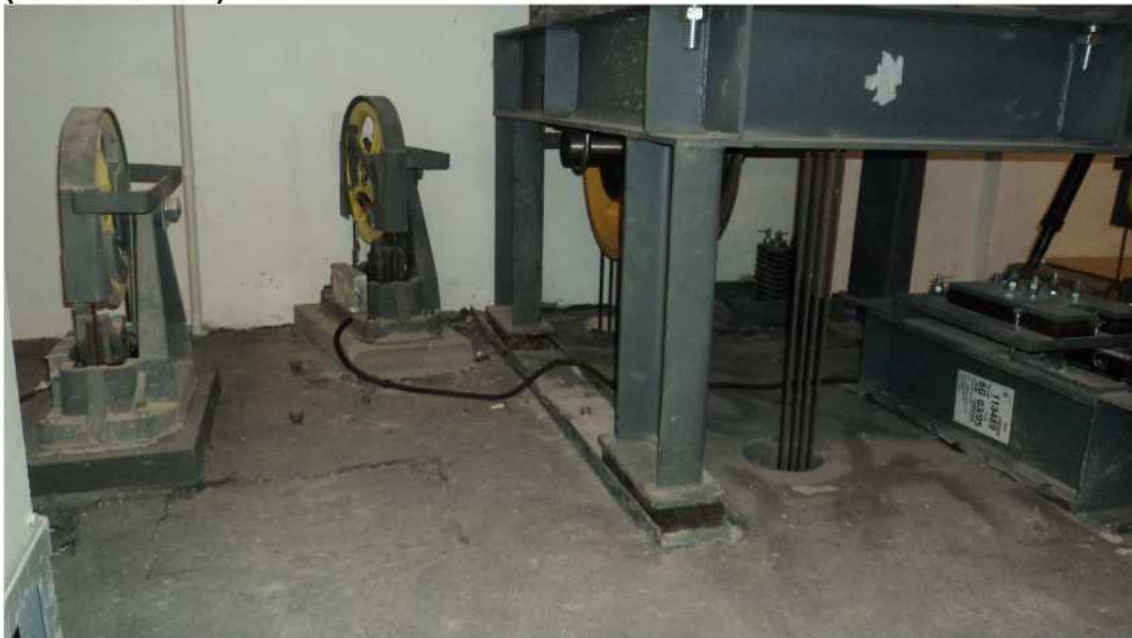
Foto 6 - Detalhe de passagem de cabamentos da máquina de tração (Obs: item 3.5)
