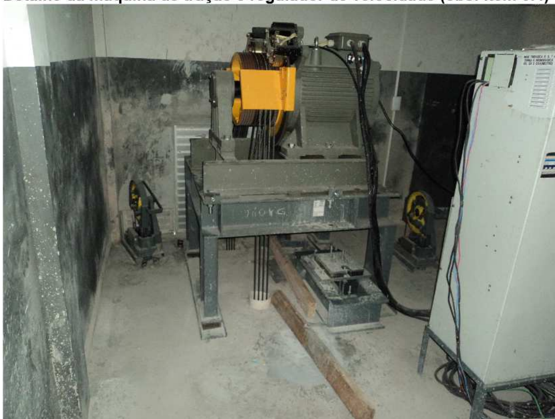
Detalhe da máquina de tração e regulador de velocidade (obs: item 3.4)
