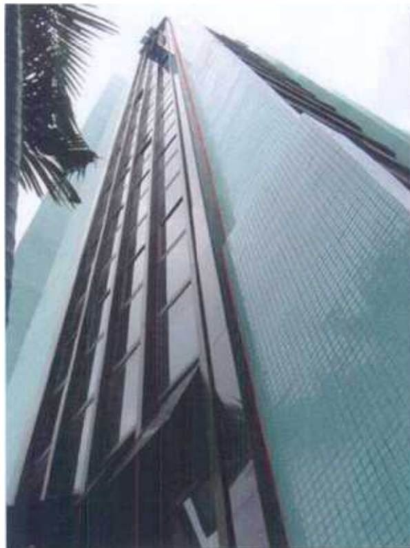
Fotografia 7 – Posicionamento da junta de movimentação vertical.
