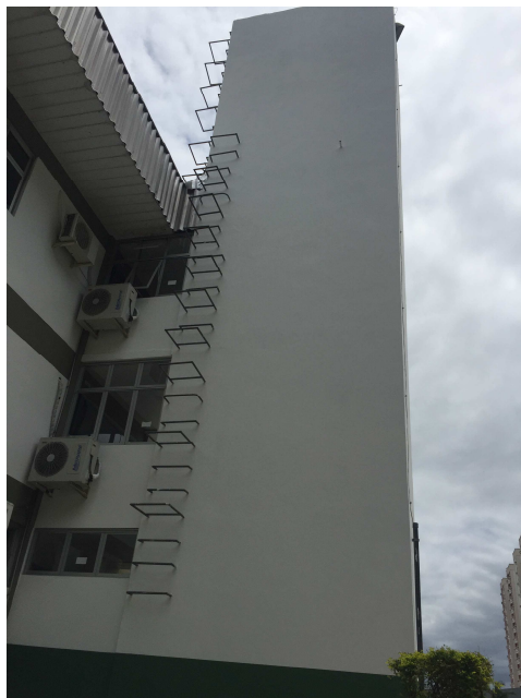
Figura 01 – Foto da escada existente
