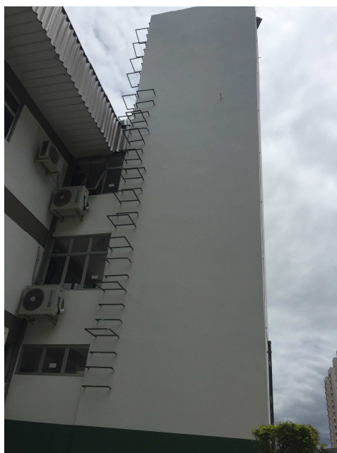
Figura 01 – Foto da escada existente
