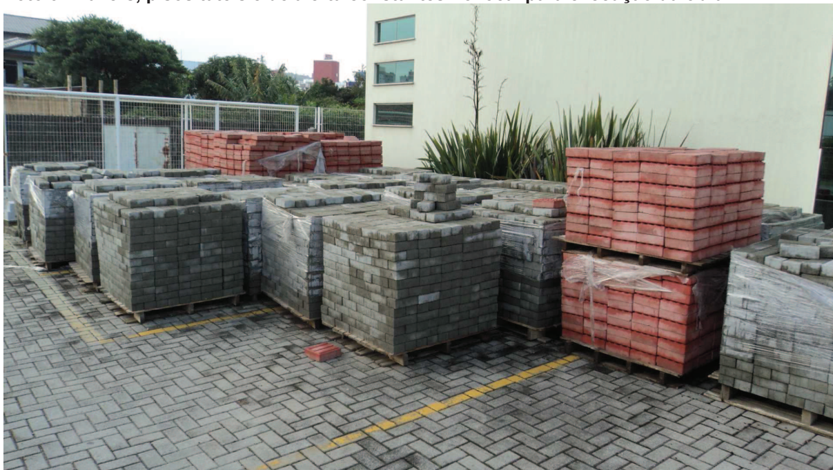
Foto 3 - Pavers, pisos táteis e de alerta constantes no local para execução da obra
