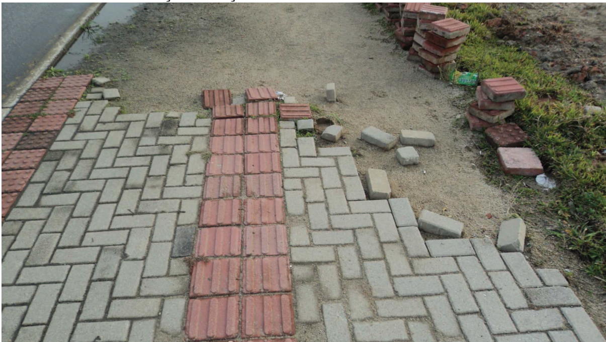
Foto 2 - Padrão de realização da calçada
