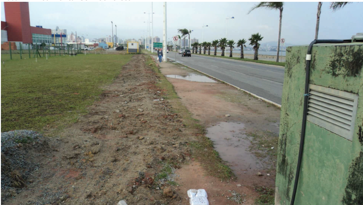
Foto 1 - Área frontal sem concreto
