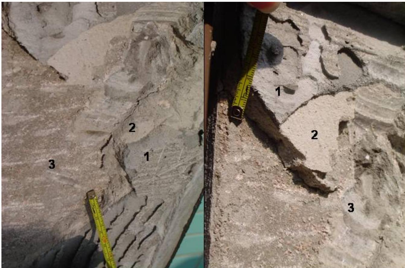
Fotografia 5 – Detalhe da base mostrada na Fotografia 4, após pequena destruição, mostrando os diferentes constituintes: 1 – Argamassa de emboço; 2 – Argamassa colante; 3 – Base resistente (argamassa forte ou concreto)
