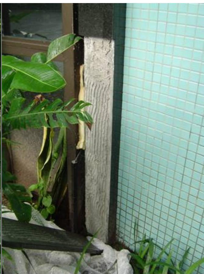
Fotografia 4 – Base de assentamento da peça mostrada na Fotografia 3, mostrando a argamassa com cordões formados pela desempenadeira denteada.
