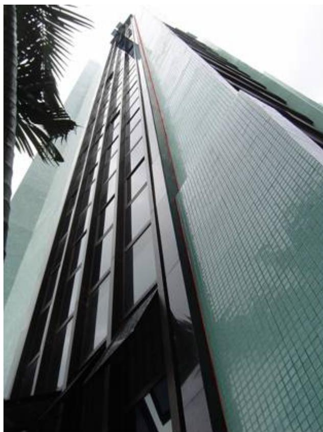
Fotografia 7 – Posicionamento da junta de movimentação vertical.
