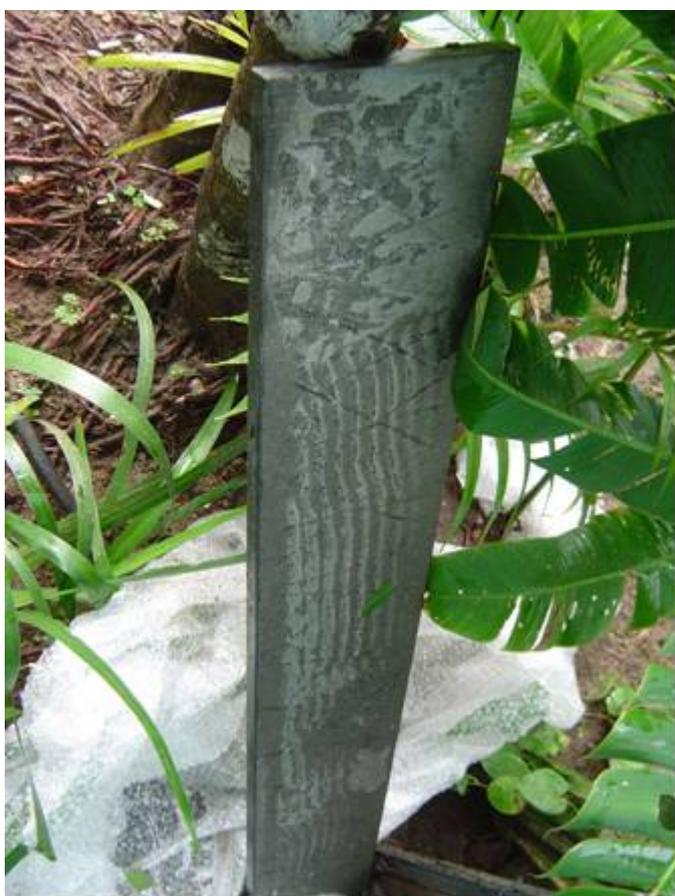
Fotografia 3 – Tardoz da peça de granito intencionalmente descolada do pavimento térreo do prédio, na fachada Sul.
